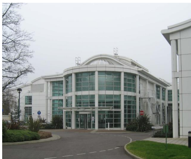
写真-1 NPLのエントランス
